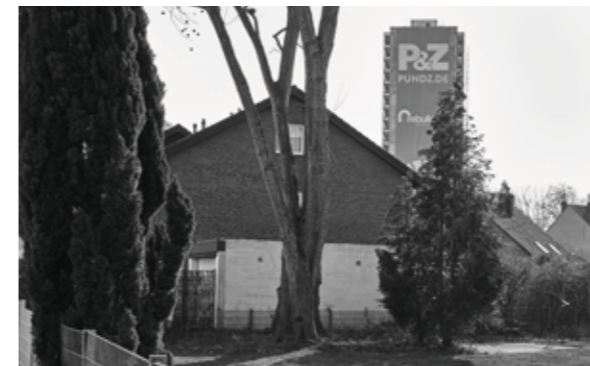
Für die „Weißen Riesen“ im Duisburger Stadtteil Hochheide musste ein Teil einer alten Bergbausiedlung weichen. Nach dem Abriss sieht der neue Flächennutzungsplan eine Grünfläche vor.
