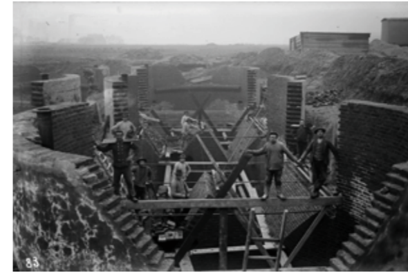
Kläranlage Bochum, Bau Emscherbrunnen, um 1925 © Emschergenossenschaft/Lippeverband
