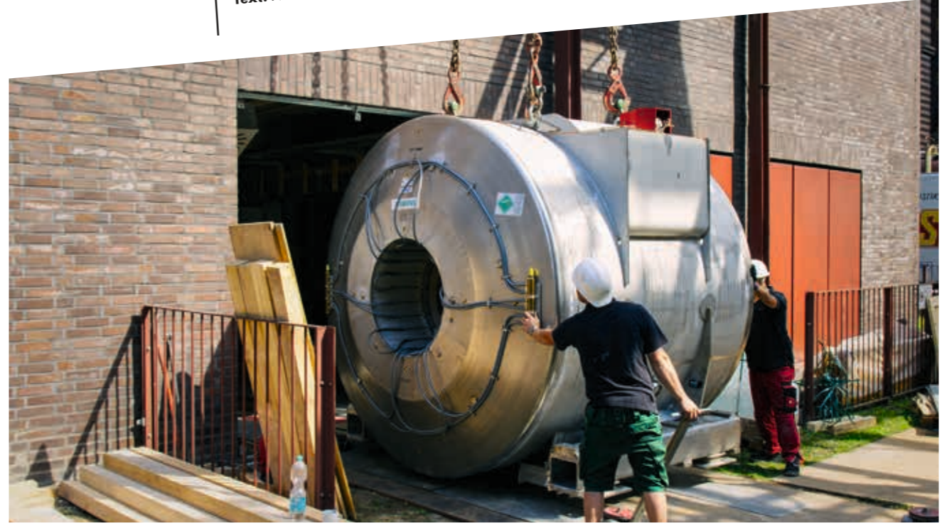
Das Runde muss durch das Eckige: Den Supermagneten ins Gebäude zu bringen, ist Maßarbeit.
